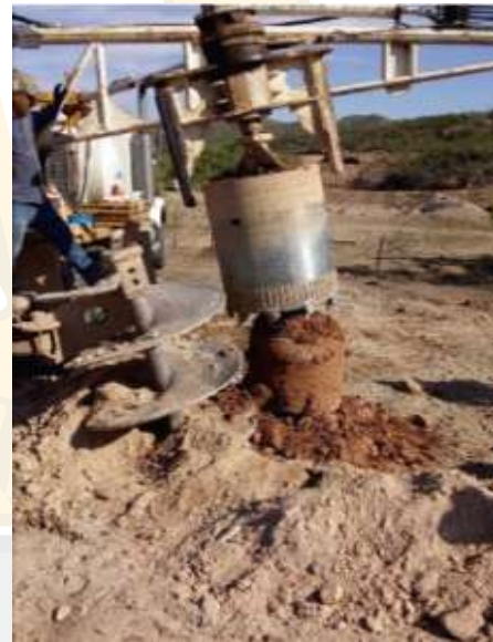
Pilas de cimentación Puente La Laborcita, San José del Sitio, Chih.
